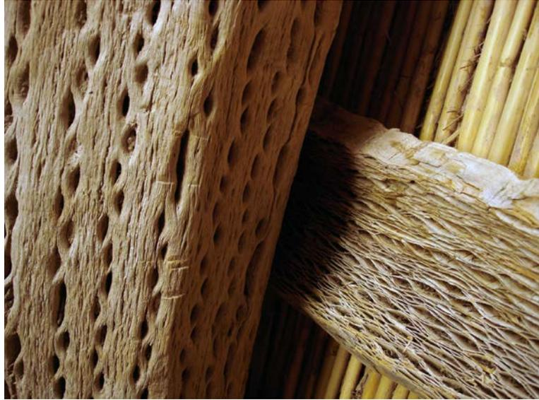
Fig. 3 (Arriba derecha) Detalle de la estructura de la cubierta en madera seca del cactus cardón (*Echinopsis atacamensis*). El sistema estructural se compone de la viga principal, similar a un cilindro aplanado que muestra la cara exterior del tronco, y la viga secundaria compuesta por una sección longitudinal del cilindro de madera de cactus donde es visible la cara interior del tejido. © Ludovica Rossi 2005
