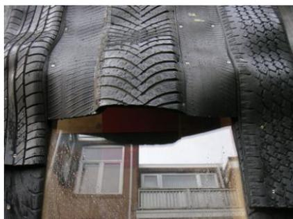
Fig. 23 Maison Gomme, proyecto de Denis Oudendijk y Jan Körbes (La Haya, Baises Bajos, 2005). La vivienda-estudio, realizada en autoconstrucción, tiene un revestimiento exterior en banda de rodadura de neumáticos recuperados. Las franjas están colocadas alternando sus caras (interior-externo) y actúan como unas tejas continuas que canalizan el agua hacia abajo. © Refunk 2005
