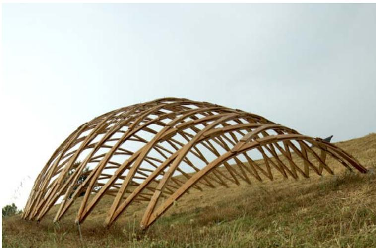
Fig. 13 Pabellón Almond, de CODA (Computational Design Affairs), ETSAV 2013. El proyecto, en el marco del curso Reset, investiga el desarrollo de cáscara elástica de doble curvatura con listones de madera planos, inicialmente rectos. La construcción se realiza a partir de listones de madera aserrada aún verde y húmedos para aprovechar las propiedades elásticas del material. Estos son curvados y cruzados para obtener una trama de curvas geodésicas. Fuente: © Soriano E., 2017
