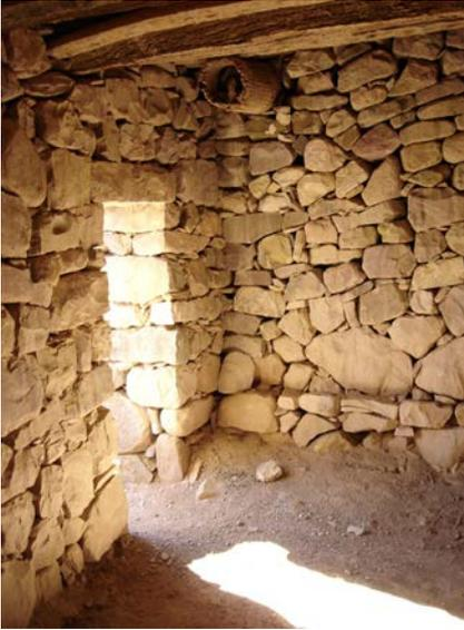
Fig. 2 (Arriba) Vista interior de una vivienda de una sola planta, con una altura interior de 1,80 m, conformada por muro de piedra en seco, techo en vigas de madera de cactus, barro y cañizo. Complejo arqueológico de Pucará de Tilcara © Ludovica Rossi 2005
